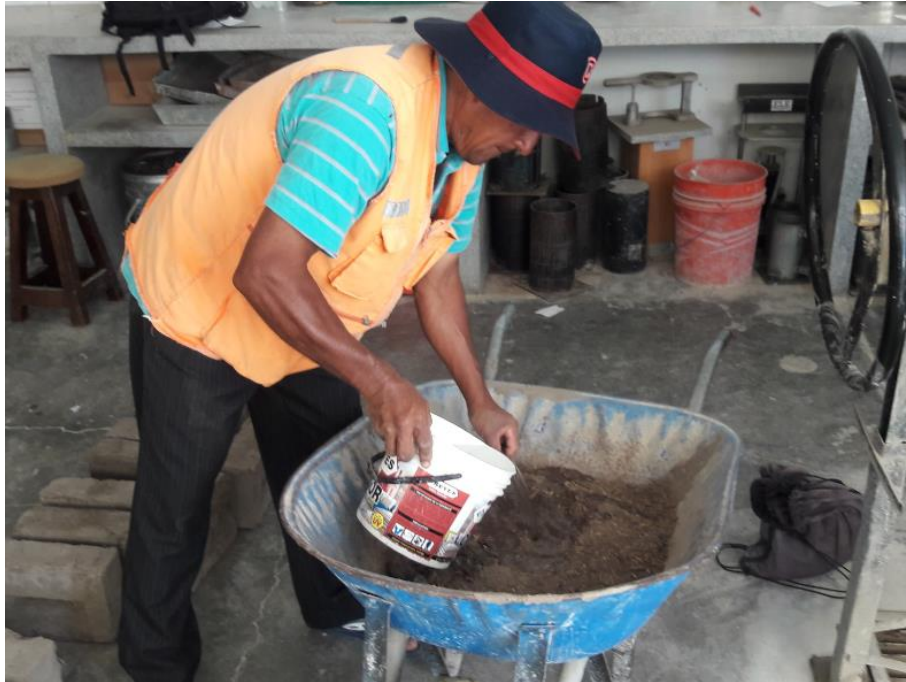
Fotografía N°03: Preparación de mezcla de tierra: paja
